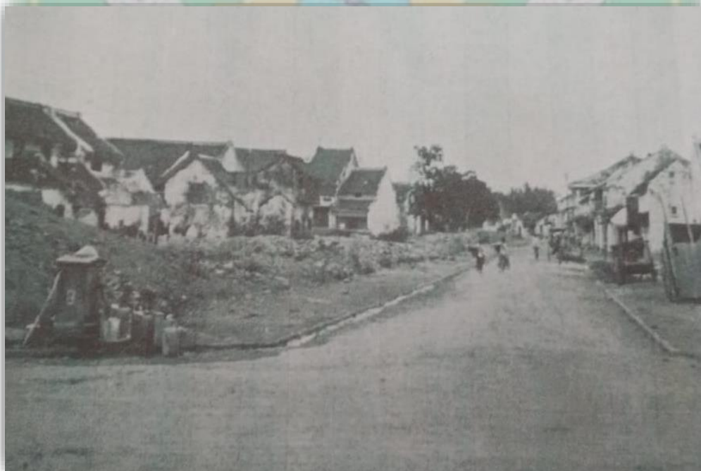
Gambar 6. Kondisi sungai “Kali Bacin” setelah di uruk dan menjadi jalan J.H. eycken (Sumber : Dinas Kearsipan dan Perpustakaan Kota Cirebon, 2008)
