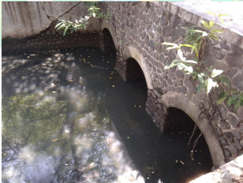
Gambar 8. Kanal galian Sungai baru “Kali Anyar” sebagai saluran pembuangan baru Sumber : Dokumentasi Penulis, Cirebon 29 Februari 2019)
