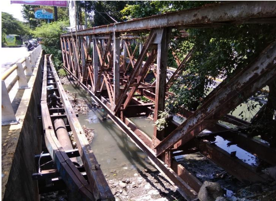
Gambar 13. Jembatan rel kereta api di atas muara sungai baru “Kali Anyar” jalur menuju Pelabuhan Cirebon
