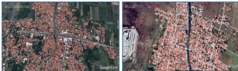
Gambar 18. Typical Bangunan di sepanjang sungai (Kec Gebang, dan Kec Pangenan)
